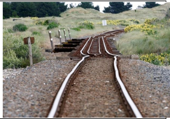
圖510 鐵軌損壞
