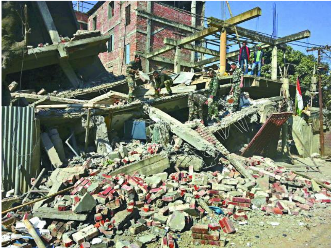
圖317 因帕爾多間民居倒塌
