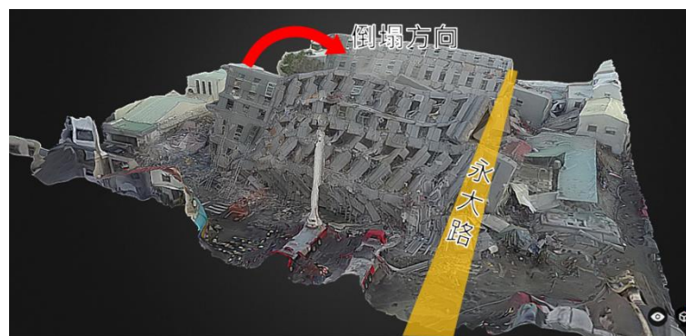
圖344 臺南永康區維冠金龍大樓倒塌
