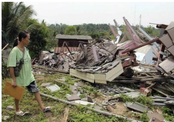
建築物損毀倒塌
