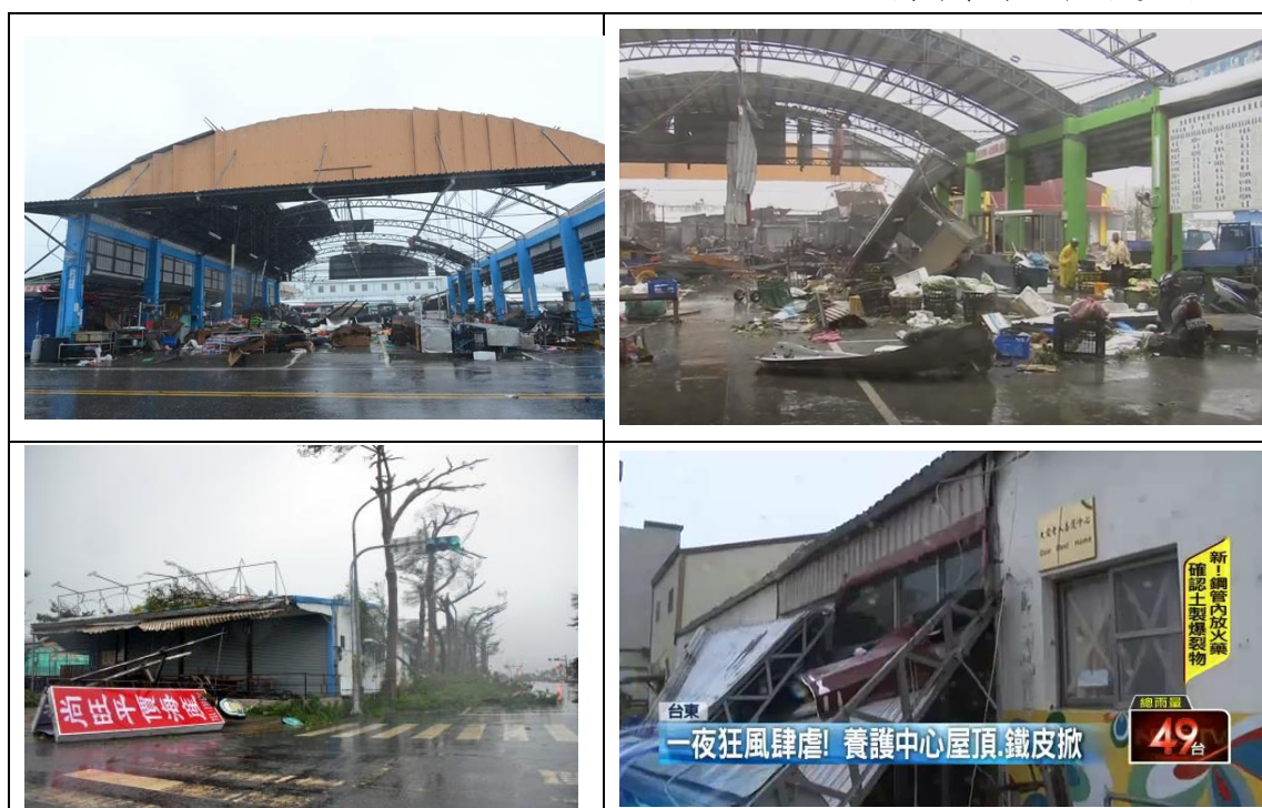
圖462 臺東果菜市場屋頂被掀及養護中心房屋損毀
