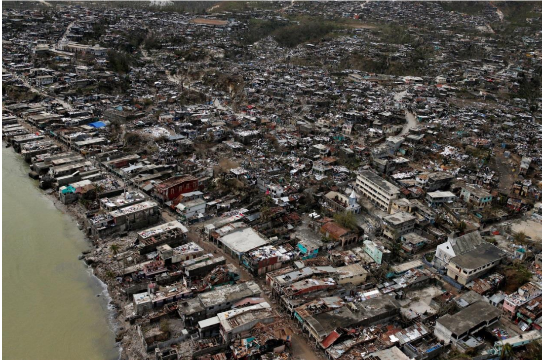
圖491 海地西南方城市熱雷米(Jeremie)有 80%房舍遭馬修颶風破壞
