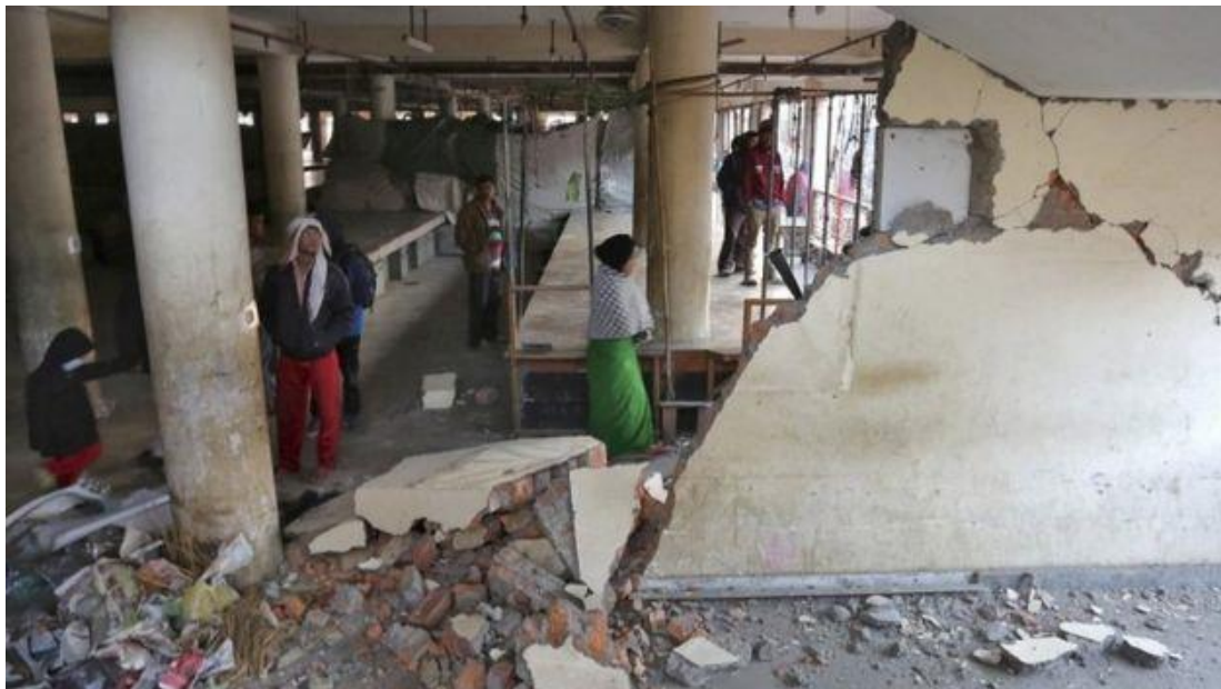
圖318 建築物倒塌情形
