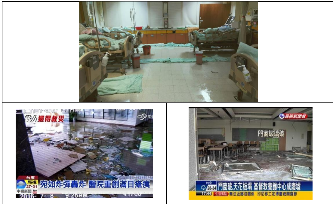
圖463 醫院嚴重損毀情形
