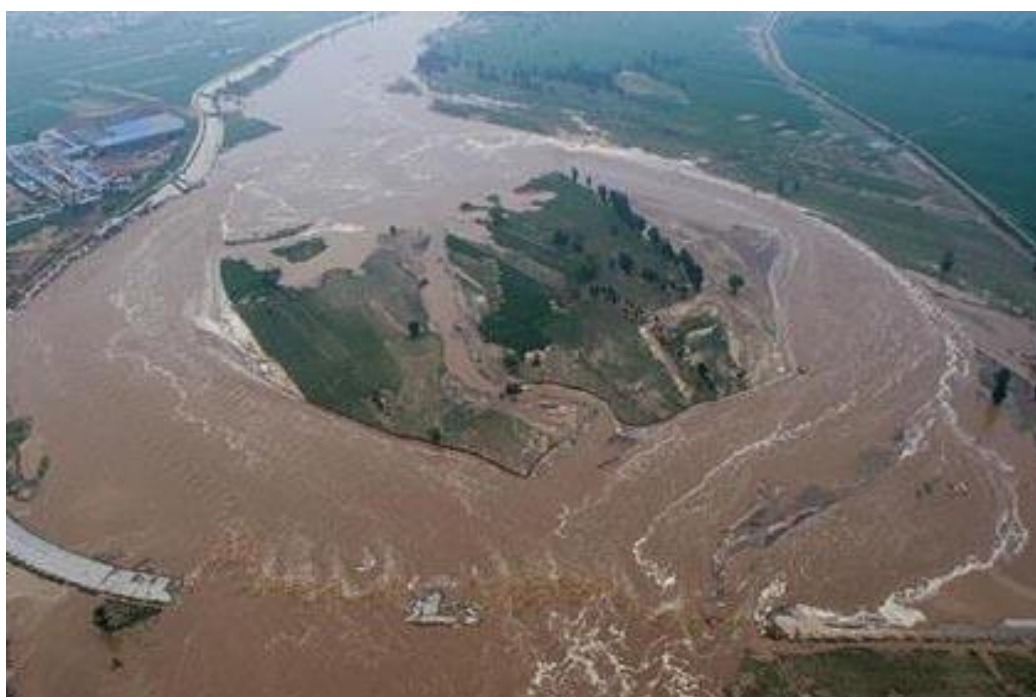
圖469 洪水潰堤情形
