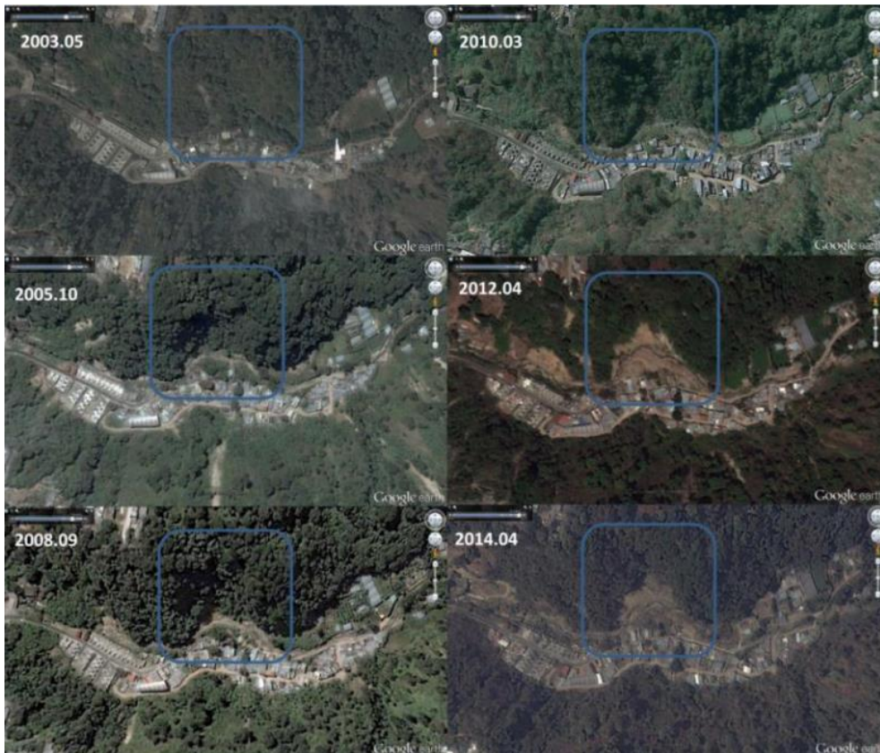
圖299 歷年邊坡土石演變過程
