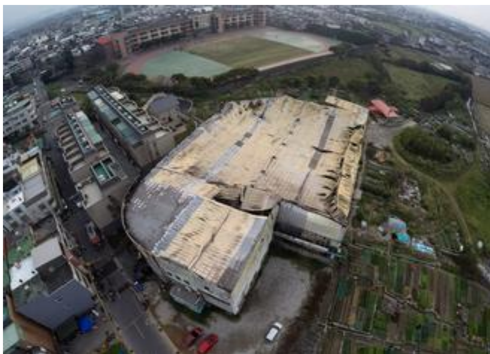
圖164 大火導致鐵皮屋坍塌
