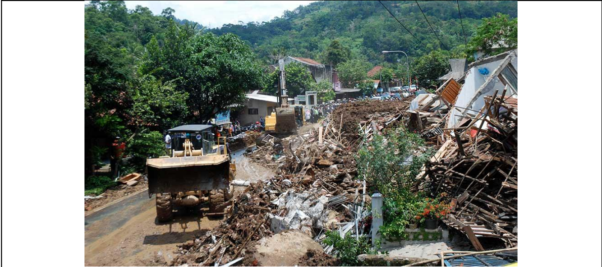
圖494 搜索隊伍使用重型機械清除倒塌物
