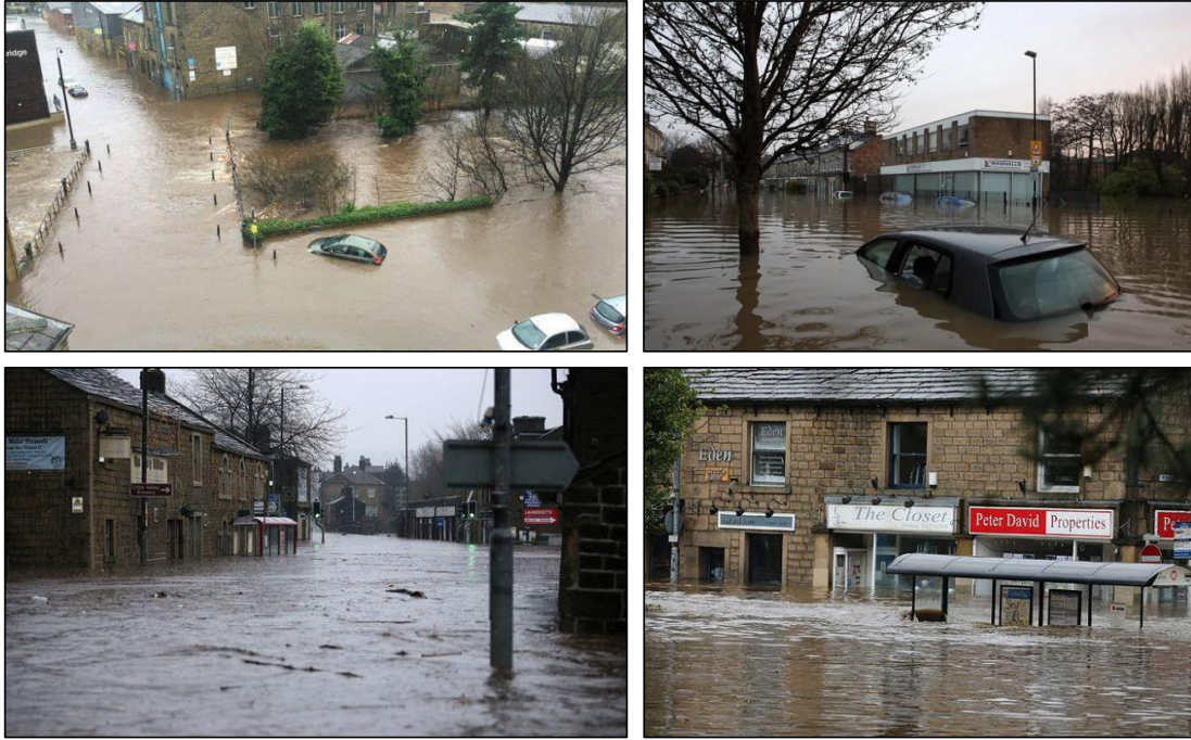
圖328 法蘭克風暴造成洪災與房屋毀損
