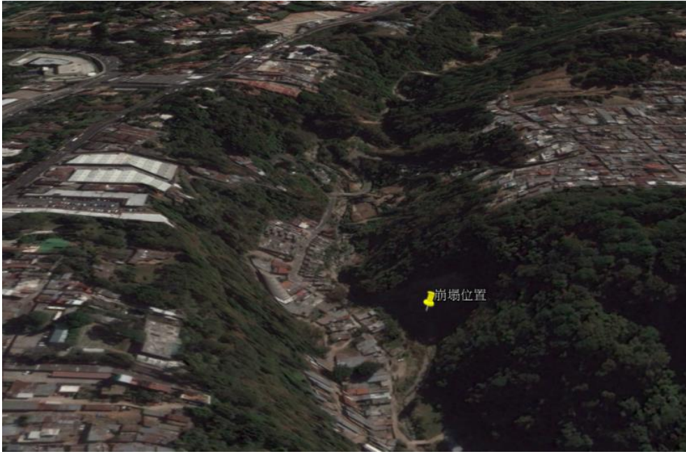
圖298 崩塌邊坡與建物相對位置
