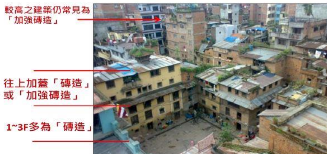
圖225 首都加德滿都仍有大量「房舍疊加（老搯少）」結構型態之建物
