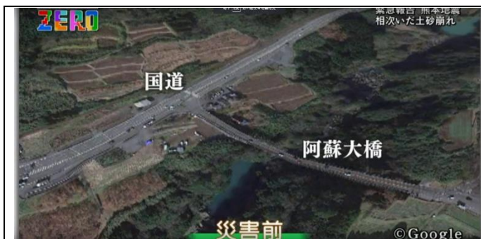
圖393 阿蘇大橋崩塌前
