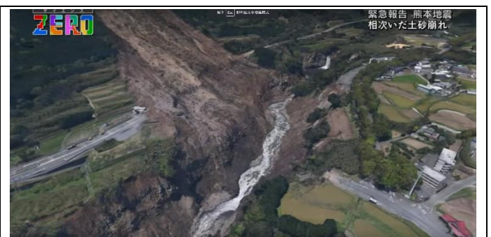
圖394 阿蘇大橋崩塌後
