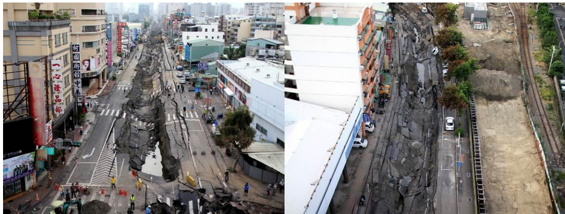
圖92 UAS 空中側拍高雄市前鎮區災點現場影像
