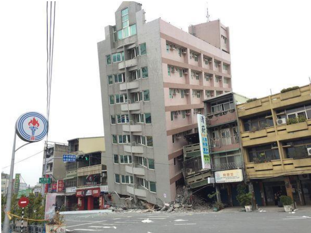
圖346 臺南新化京城銀行大樓嚴重傾斜 75 度角成危樓。
