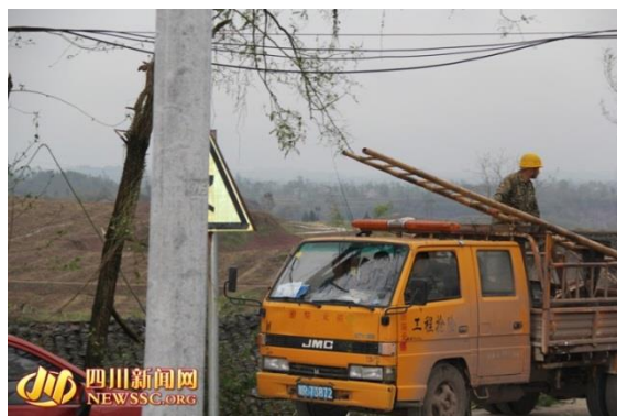
圖213 電力、通訊搶修
